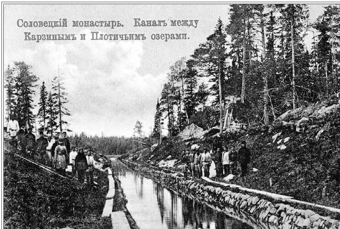
Строительство канала. Открытка нач. XX в. Из собрания А.И. Сидорова
