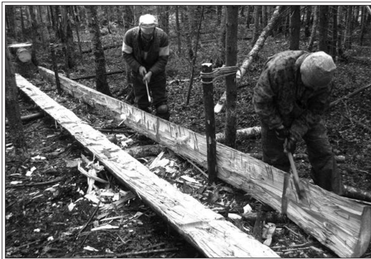
Изготовление набоев при реконструкции — бревно (ель) расколото пополам и обтесывается. Октябрь 2012 г.
